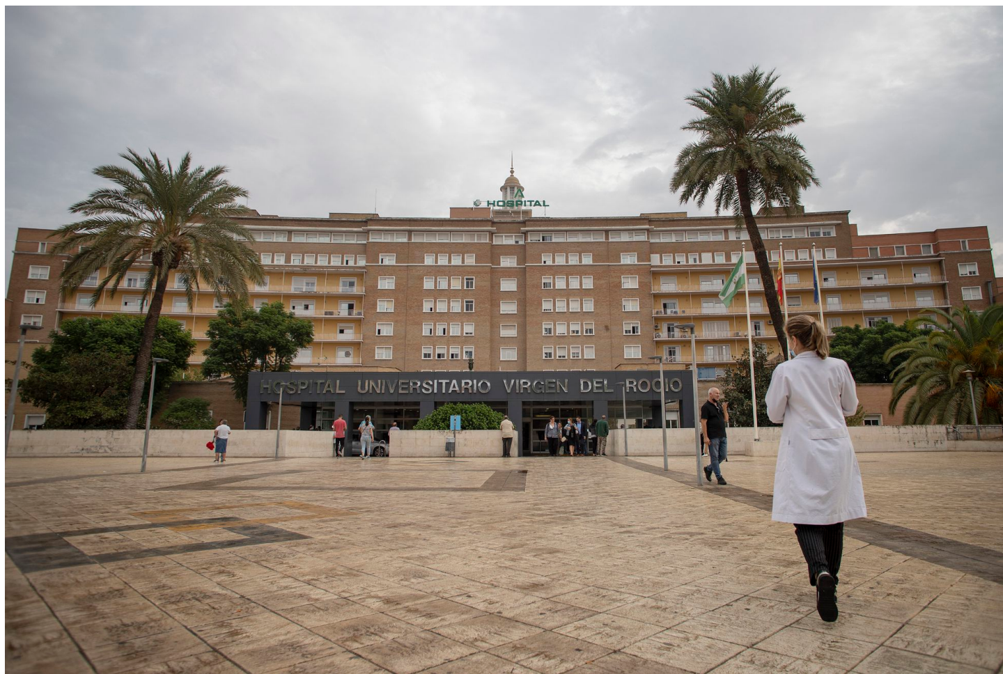
Fachada del Hospital Virgen del Rocío, en Sevilla. PACO PUENTES
